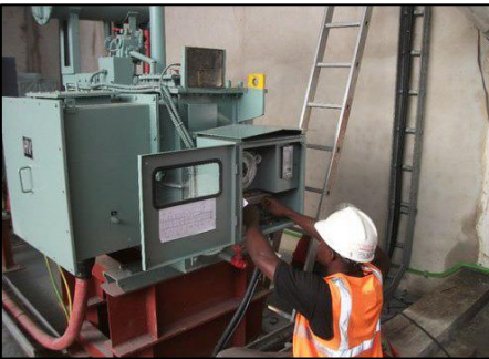
Manutenção Correctiva de um Transformador de Potência de 500kVA - Maputo
